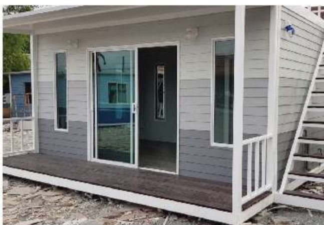
บ้านประกอบเสร็จ
